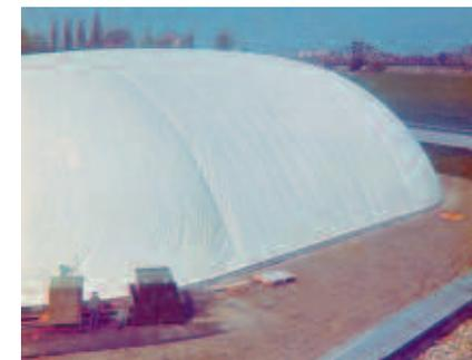
41 Aufgrund der unsicheren Wirtschaftslage lösen wir unser Lagerproblem mit einer Traglufthalle. Die Halle stand innerhalb von 45 Minuten, 1973
