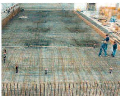
43 Viele 100 Tonnen Beton-Eisen garantieren die Tragfähigkeit für die grossen Produktionsmaschinen
